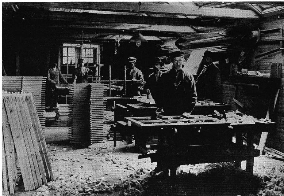
Interiör från Jakobsson & Erikssons snickeriavdelning, belägen på Sofiehem. Några snickare sysslar med fönstertillverkning. Per Eriksson själv syns i kubb längst till höger. Foto: VLM:s samlingar.
